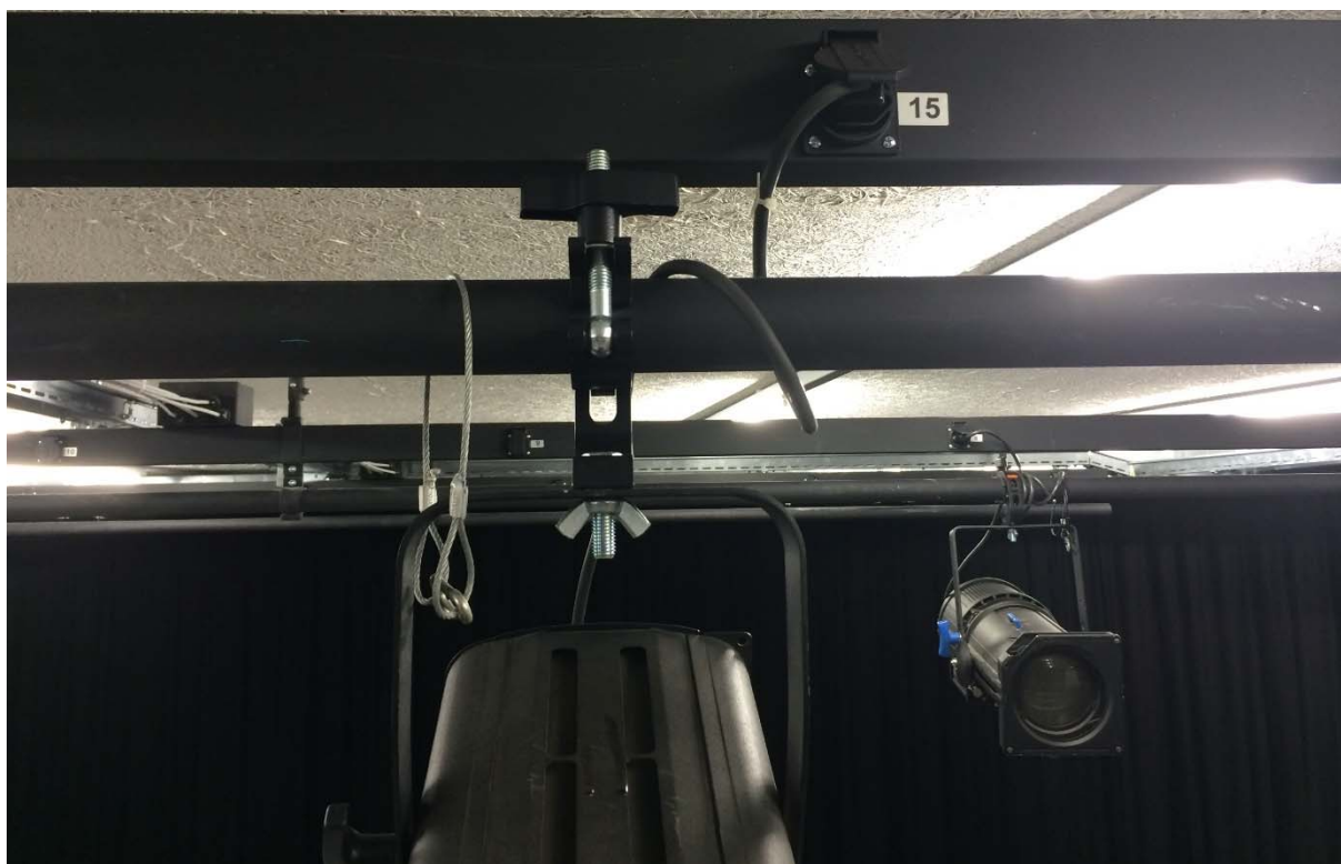
Blick auf Steckleisten an Aufhängevorrichtungen
