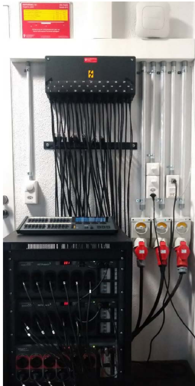
Leistungsrack, Lichtsteuerpult und Anschlüsse
